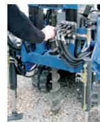
Echantillonnages par forage Probeentnahme mit Drehbohrungen
